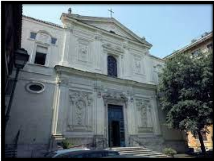
CHIESA S. MARTINO AI MONTI IN ROMA LAVORI DI RESTAURO DELLE COPERTURE E RIFACIMENTO DELLE GRONDE. RIFACIMENTO DI PARTE DEGLI STUCCHI DEL CORNICIONE
