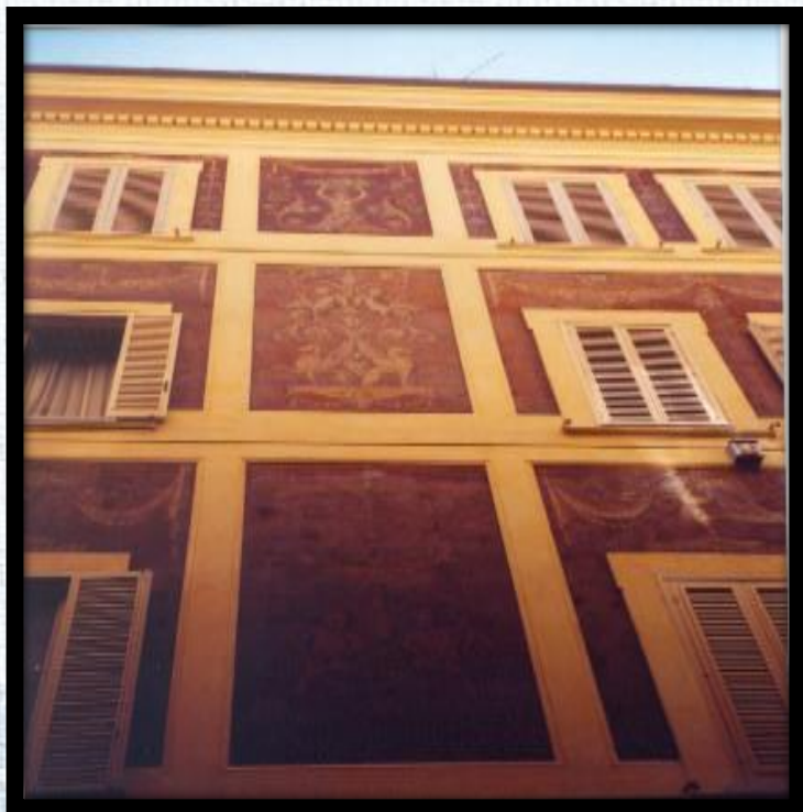
CONDOMINIO VIA FRATTINA N° 119, ROMA LAVORI DI RESTAURO FACCIATA RIFACIMENTO PARZIALE DEGLI STUCCHI DEL CORNICIONE
