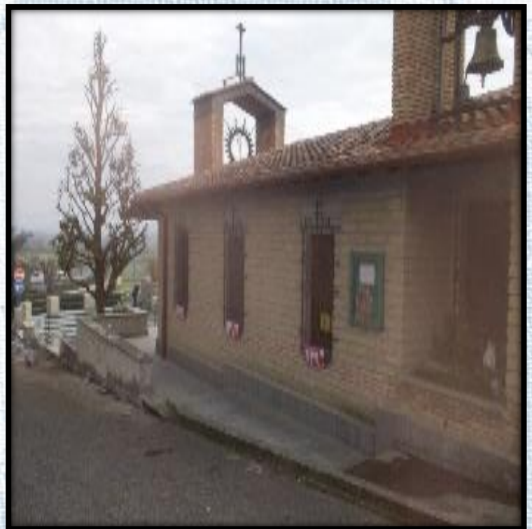
CHIESA BORGO S' ISIDORO, COMUNE DI ROMA, LAVORI DI MANUTENZIONE ORDINARIA E STRAORDINARIA; RIFACIMENTO DEL TETTO E DELLE AREE ESTERNE
