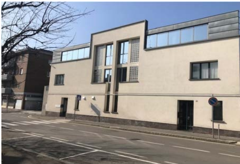
Ingresso da Via Borghetto
